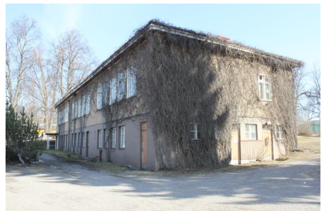
Kuivahoitotilakennus valmistuttuaan ja vuonna 2023.
