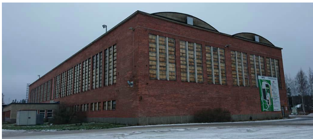
Kuva 9. Heinolan rakennusinventoinnin 2014 Högforsin tehtaan ja konttorin arvoluokan I alueella 36 sijaitseva teollisuushalli (alkuperäinen käyttötarkoitus kattilahitsaamo), rakennettu 1954, laajennettu 1955) (Kuva 7 nro 2)
