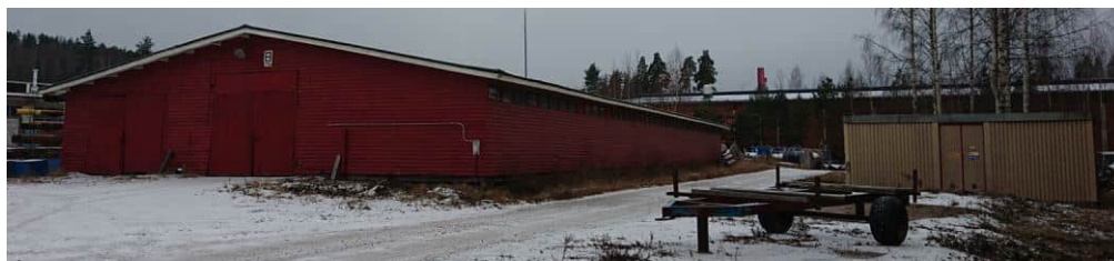
Kuva 12. Asemakaavamuutoksen teollisuus- ja varastoalueella (T-12) sijaitseva vuonna 1965 rakennettu rakennus (alkuperäinen käyttötarkoitus radiaattorivarasto) (Kuva 7 nro 5) ja pienempi muuntamorakennus
