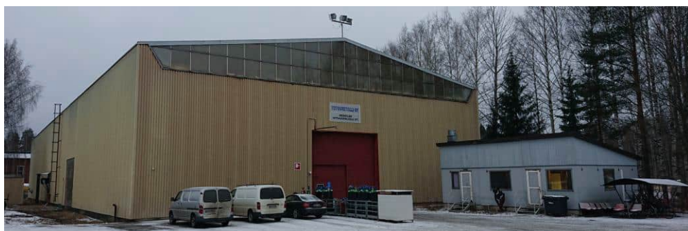
Kuva 11. Asemakaavamuutoksen teollisuus- ja varastoalueella (T-12) sijaitseva vuonna 1975 rakennettu tehdasrakennus ja pienempi vuonna 2004 rakentunut sosiaalitalo- rakennus (Kuva 7 nro 4)
