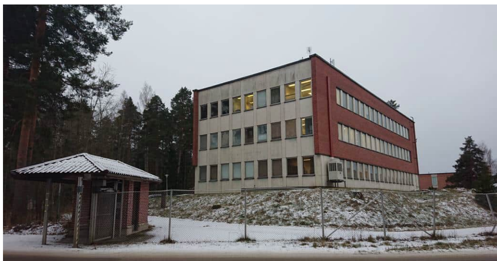
Kuva 8. Heinolan rakennusinventoinnin 2014 Högforsin tehtaan ja konttorin arvoluokan I alueella 36 sijaitseva toimistorakennus (alkuperäinen käyttötarkoitus konttorirakennus, rakennettu 1967) (Kuvan 7 nro 1)
