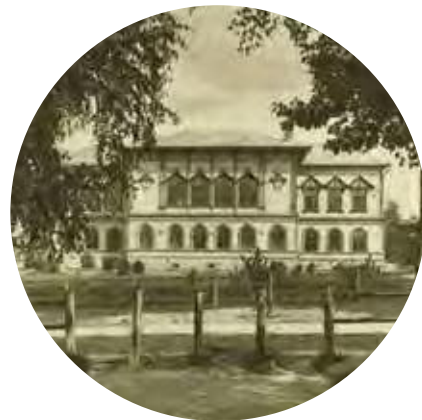
Heinolan Seminaarin päärakennus puiston pääteenä kuvattuna vuonna 1903. /HKMA
