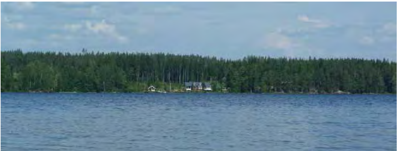
Kuvat 15. Kasvillisuuden poisto tontilta tulisi tehdä harkiten. Suojaavaa puustoa tulisi jättää. Vaaleat julkisivudetaljit näkyvät pitkälle kaukomaisemassa ja metsän poiston yhteydessä kadonnut metsän reunavyöhyke korostaa rikkonaista vaikutelmaa.
